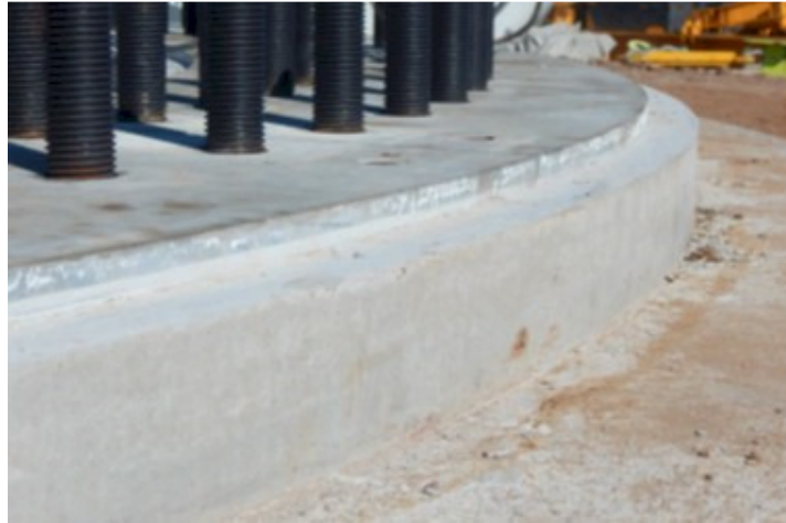
Grout aerogenerador 54
