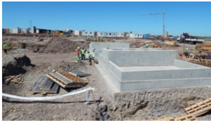
Cimentación transformadores
