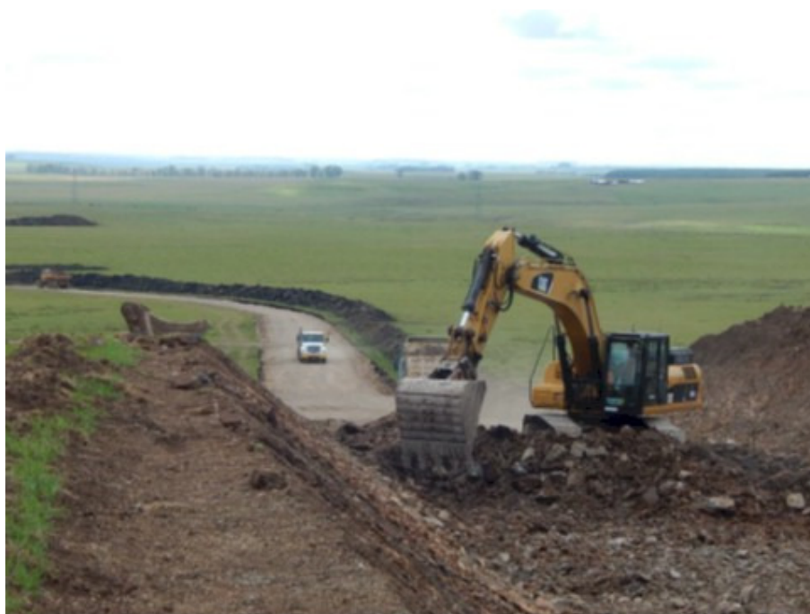
Caminería y movimiento de suelos
